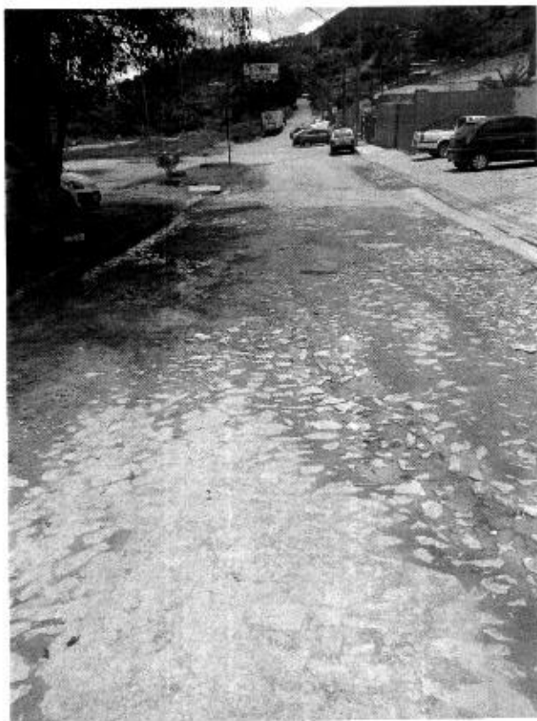
124-Escória rua Sacramento, bairro Feixos
