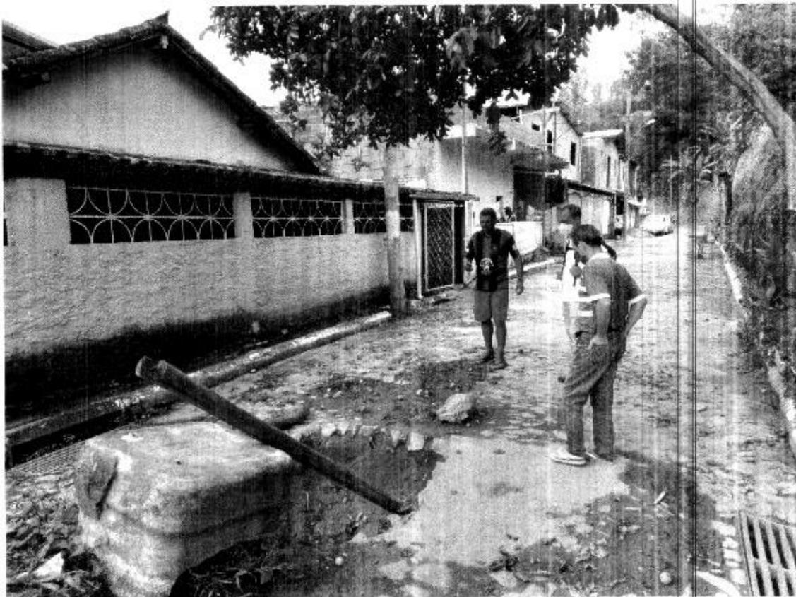
**Figura 6 – Buraco Rua B – Moradores suspeitam de problema na rede pluvial ou entupimento de bueiro**
