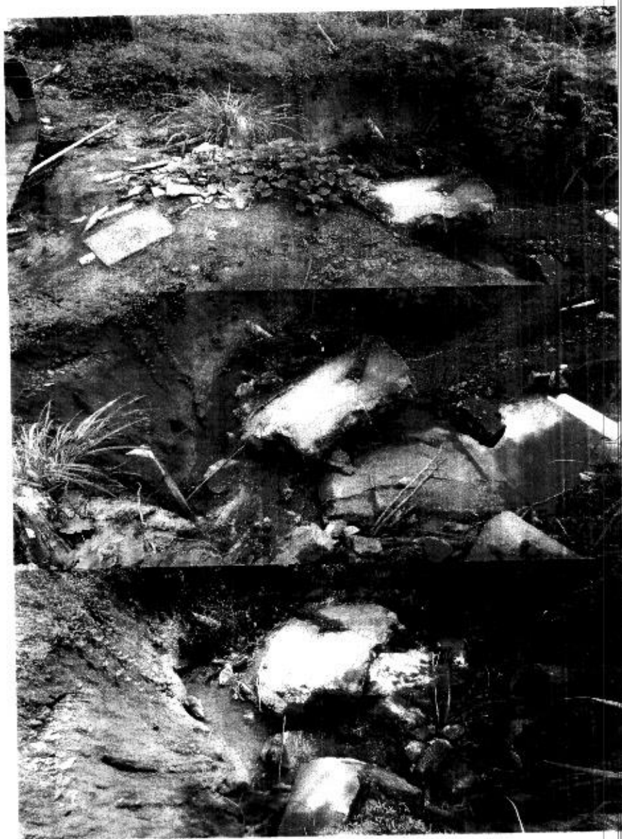
Figura 1 – Córrego na Rua Camélia causa alagamentos
