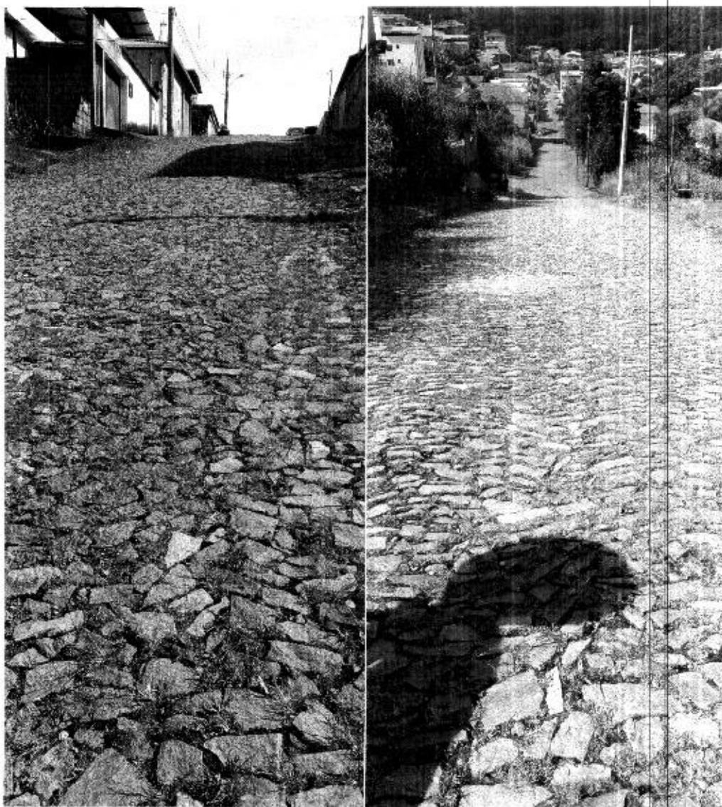
Figura 1 – Moradores reivindicam asfaltamento da Rua Matipó
