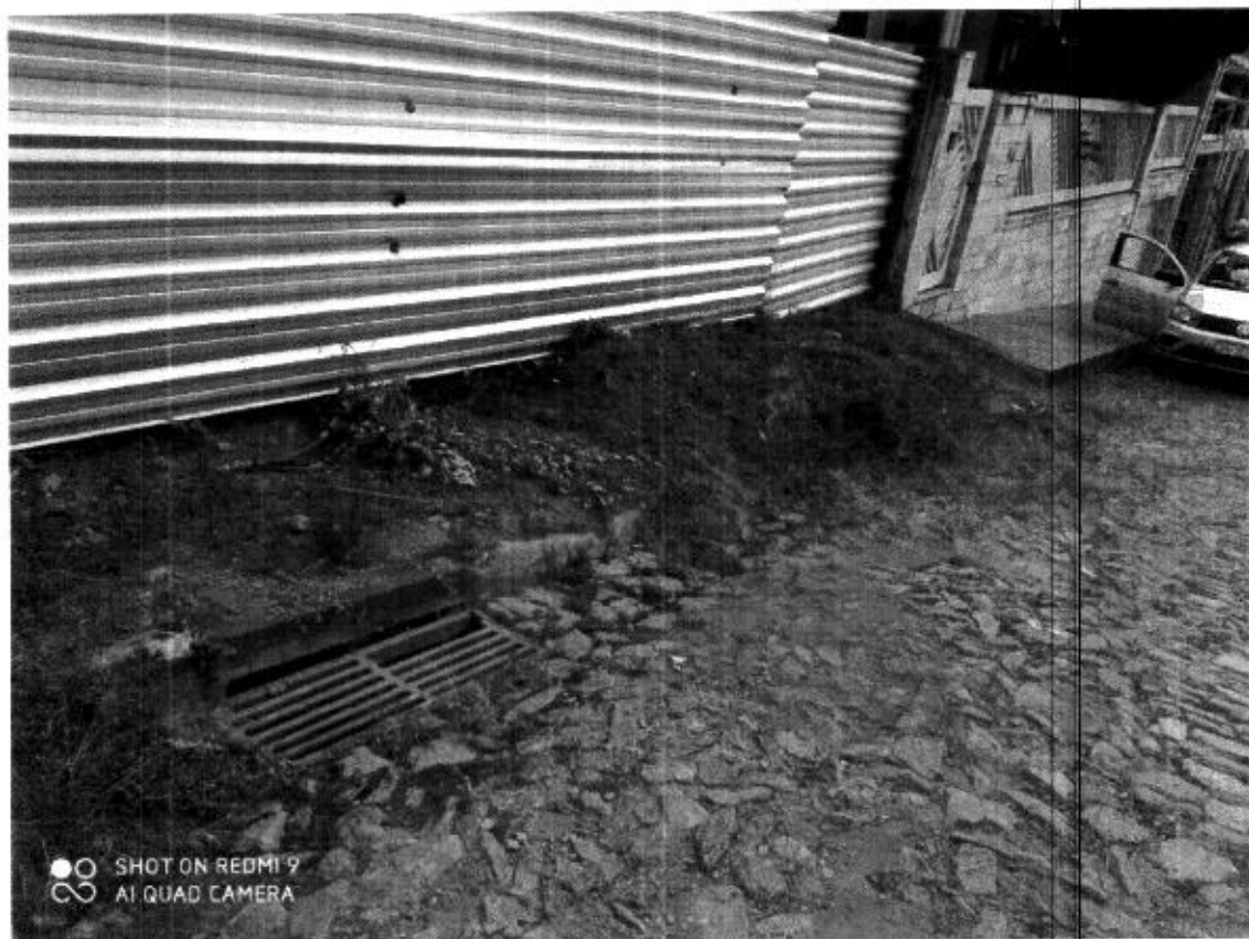
DESOBSTRUÇÃO DE BUEIROS RUA BICAS PROX. Nº 67 BAIRRO LOURDES
