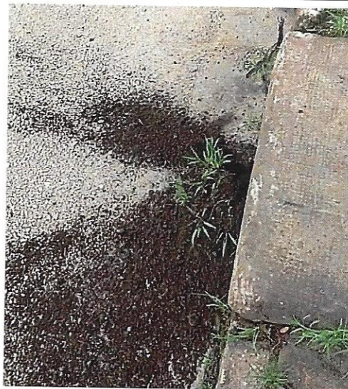
29 – Belmonte - Av Wilson Alvarenga, 4533 (próximo da Brunauer, em frente aos galpões da Arcelor)
