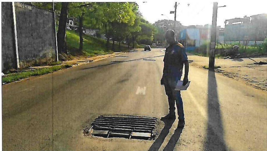
Av. Wilson Alvarenga, próximos a trincheira
