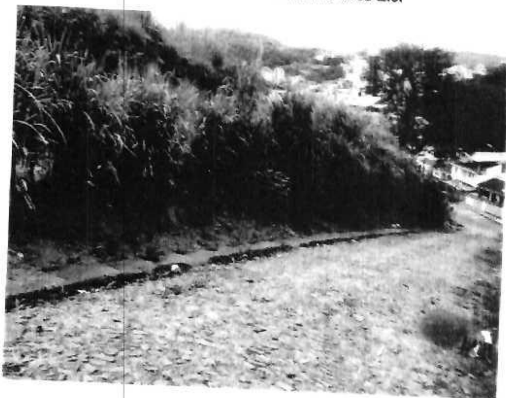
Escada rua Pedra Azul, bairro José Elói
