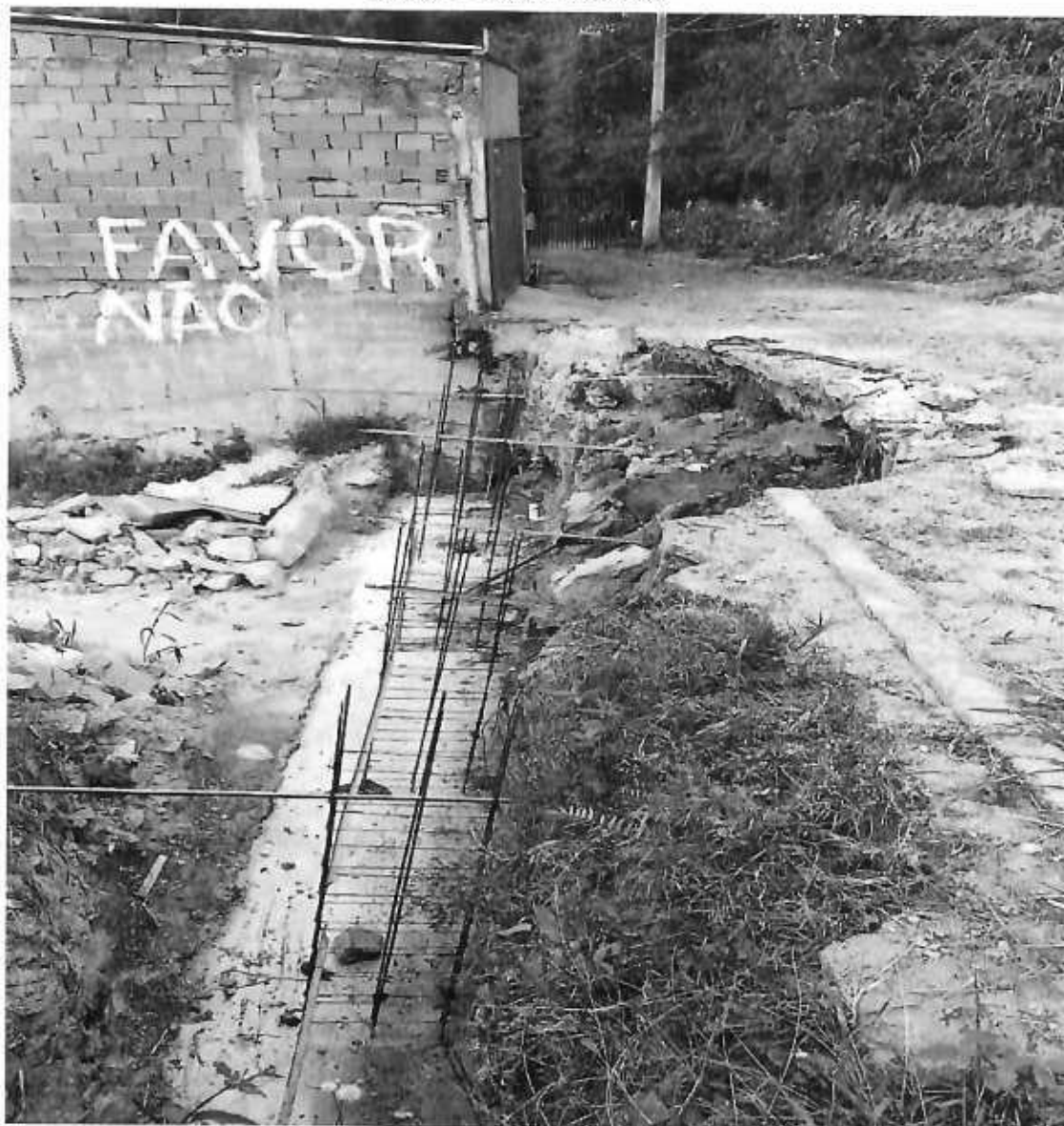
FOTO 1 – INÍCIO DA OBRA
