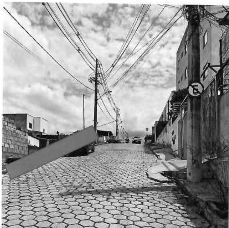
Instalação de Placa Proibido Estacionar na localização em frente ao Residencial Vale Verde, na rua Azaleia, no bairro Campos Elísios.
