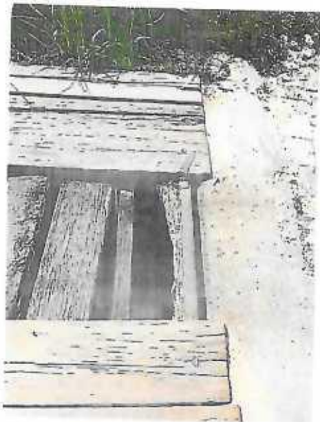
020-reparo na ponte Santa Cruz
